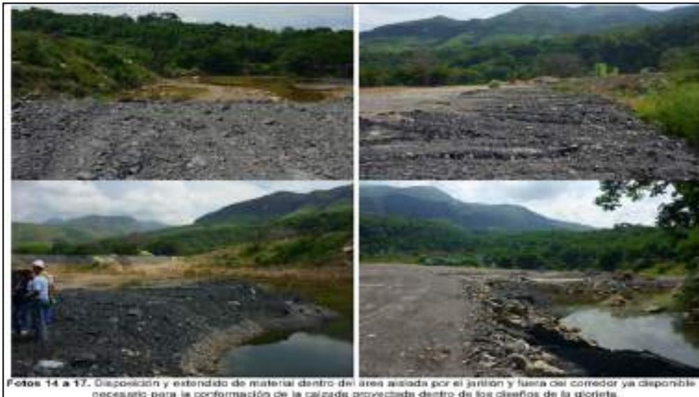
Fotos 14 a 17. Disposición y extendido de material dentro de áreas aislada por el jarillón y fuera del corredor ya disponible y necesario para la conformación de la calzada proyectada dentro de los límites de la gicrieta.
