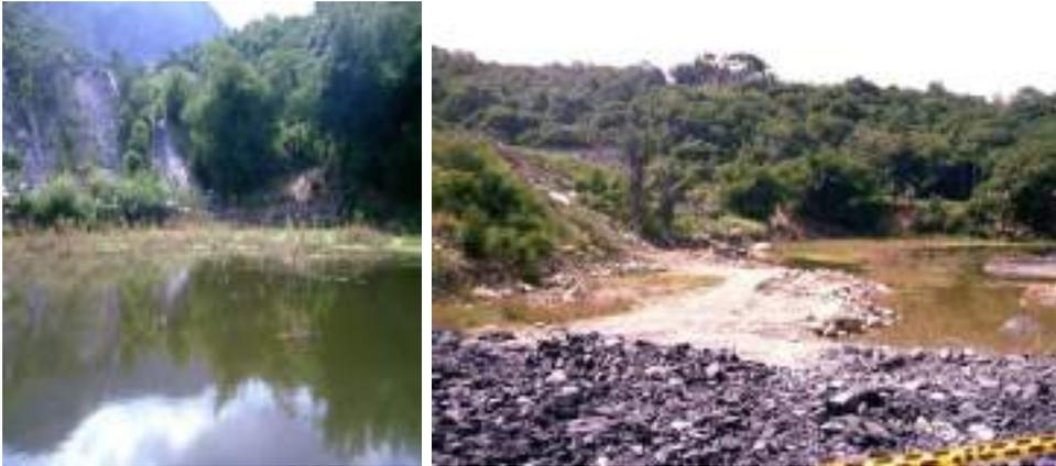
**Fotos 10 y 11.** Aguas represadas de la quebrada La Golondrina, por el cierre del meandro del río Sumapaz y la ausencia de estructuras que permitan que durante el desarrollo de las obras el agua drene permanentemente.
